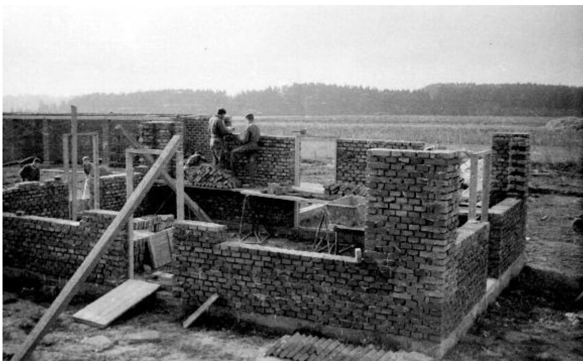
Stavba hospodářské budovy
